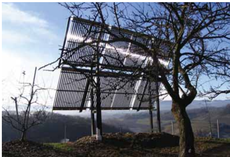
PROSTOSTOJEČI VAKUUMSKI SONČNI KOLEKTORJI
