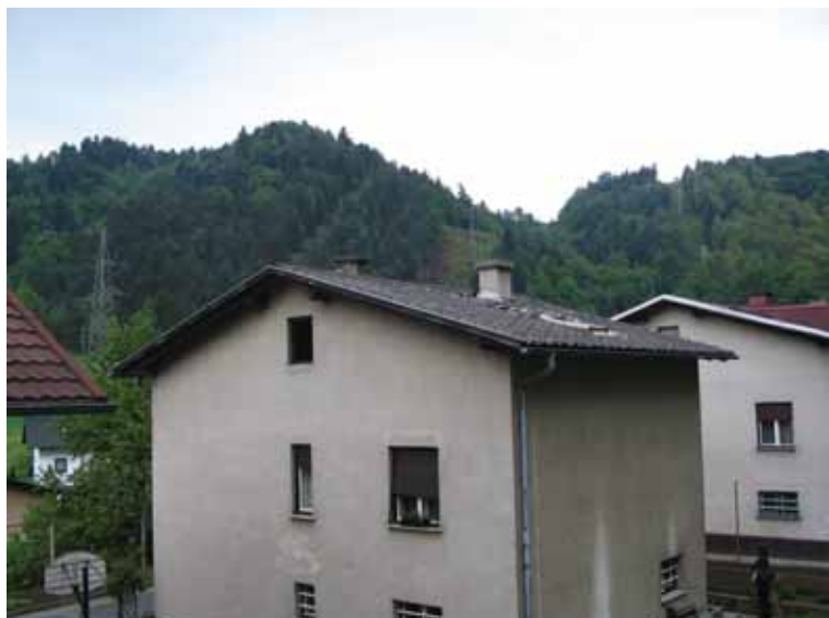
AZBEST CEMENTNA KRITINA PRED ZAMENJAVO
