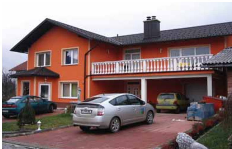
TOPLOTNA IZOLACIJA FASADE IN VGRADNJA ENERGIJSKO UČINKOVITIH OKEN
