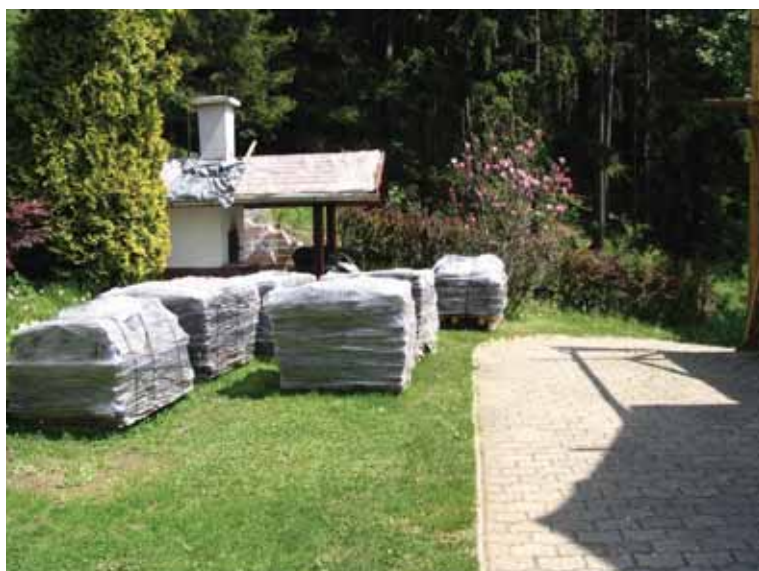
ODSTRANJENA IN NA USTREZEN NAČIN PRIPRAVLJENA AZBESTNA STREŠNA KRITINA ZA ODVOZ
