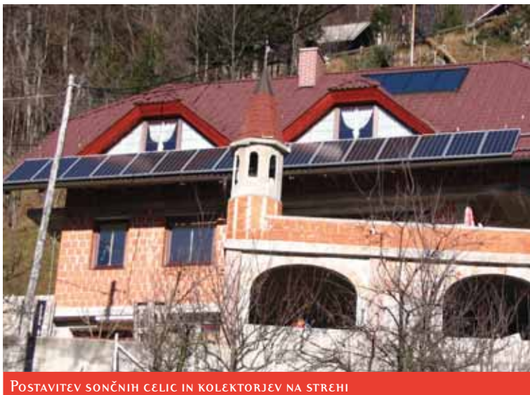
POSTAVITEV SONČNIH CELIC IN KOLEKTORJEV NA STREHI
