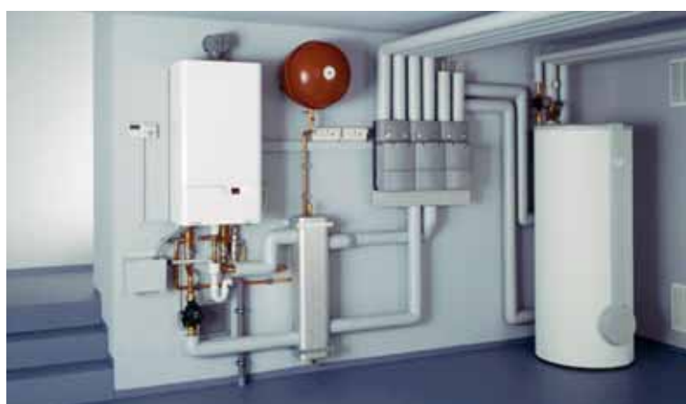
KONDENZACIJSKI KOTEL NA PLIN
