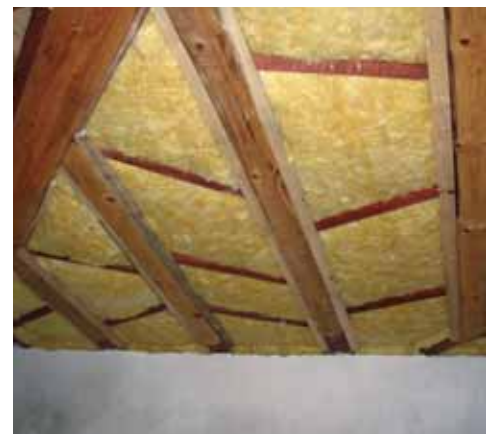
TOPLOTNA IZOLACIJA PODSTREŠJA
