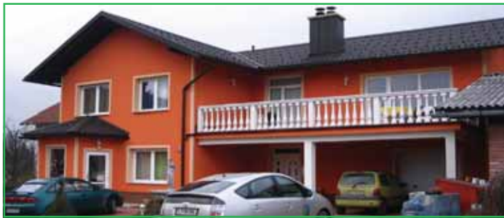
Toplotna izolacija fasade in vgradnja energijsko učinkovitih oken
