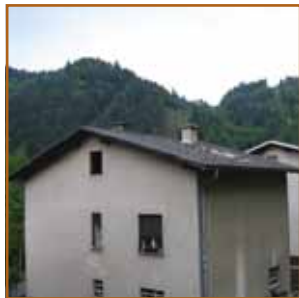
Azbest cementna kritina pred zamenjavo
