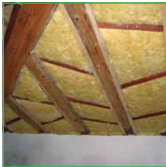
Toplotna izolacija podstrešja
