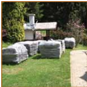
Odstranjena in na ustrezen način pripravljena azbestna strešna kritina za odvoz
