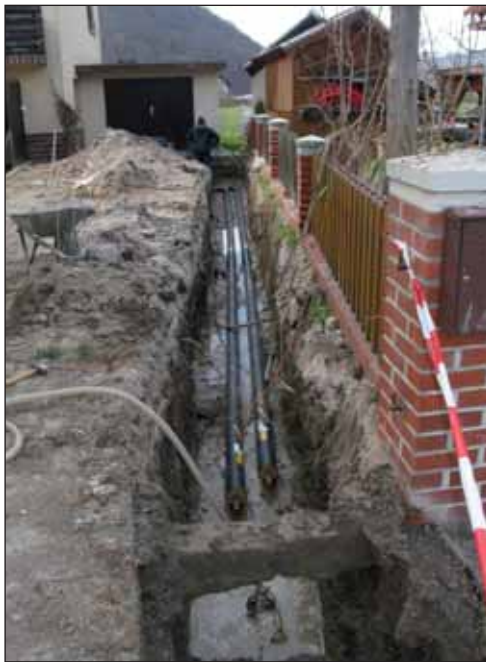
Toplovod med gradnjo
