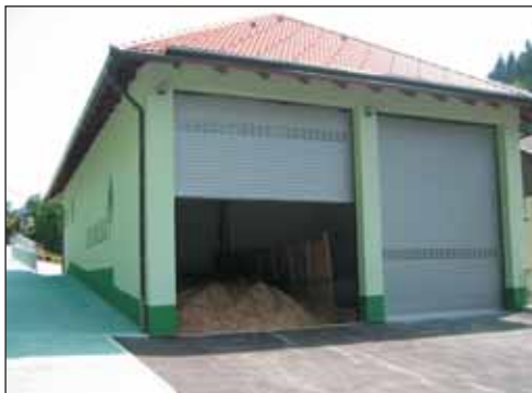
Kotlovnica v Lučah z zalogovnikom lesnih sekancev
