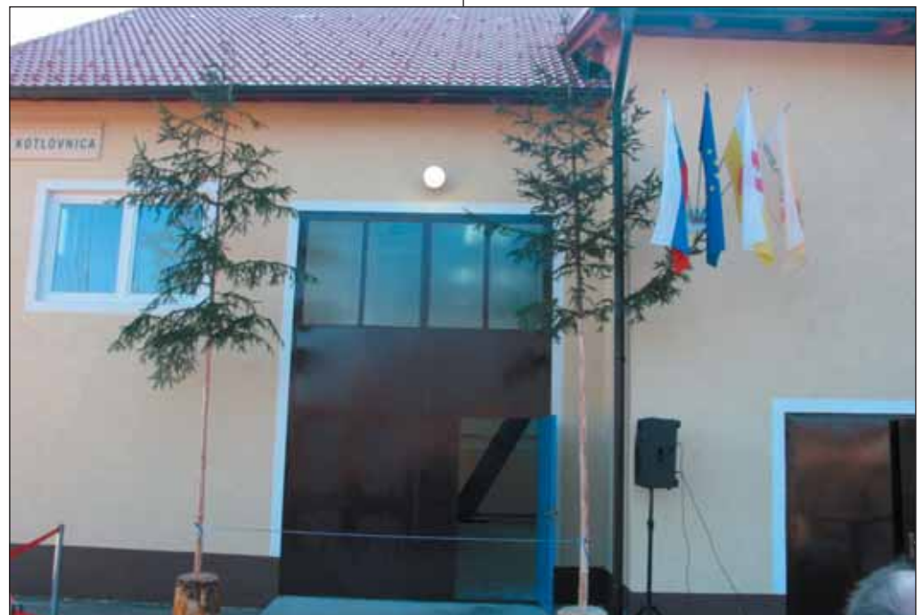
Kotlovnica na lesno biomaso ob otvoritvi
