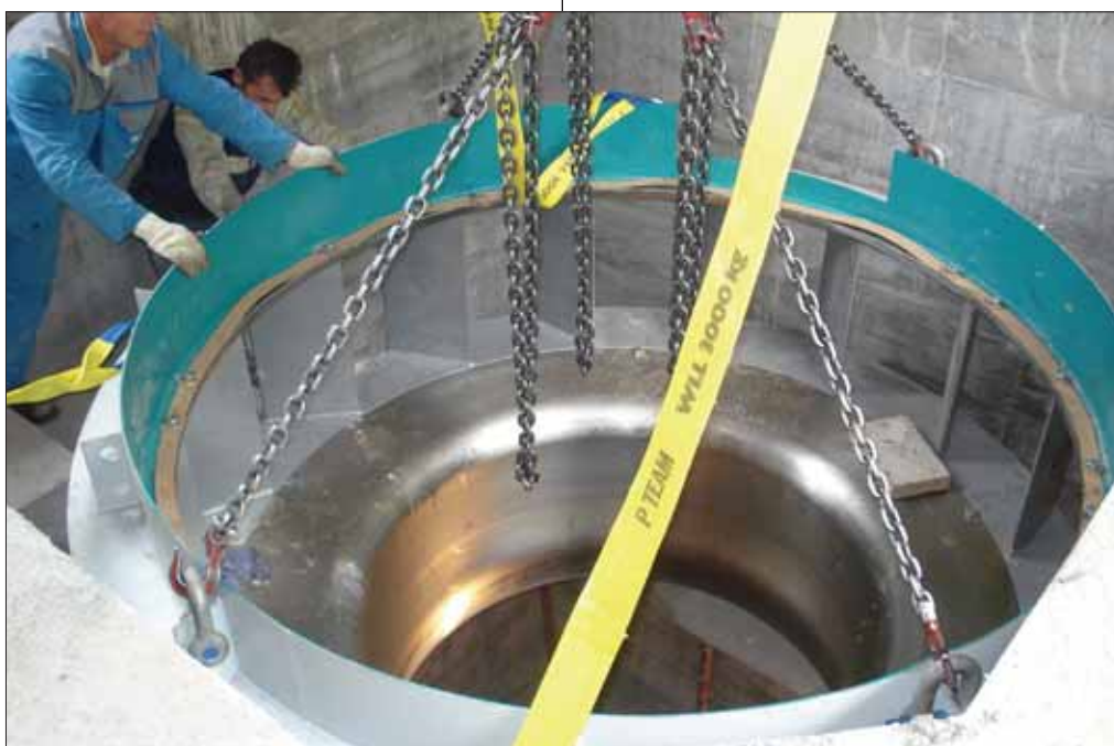
Vgradnja strojne opreme v strojnici
