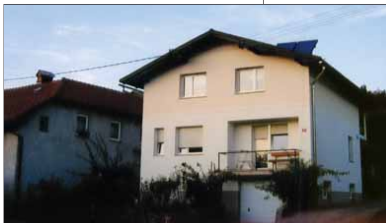
Hiša z obnovljeno fasado
