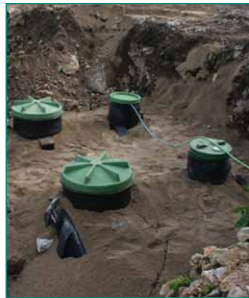
Zbiralnik deževnice in čistilna naprava v enotnem izkopu
