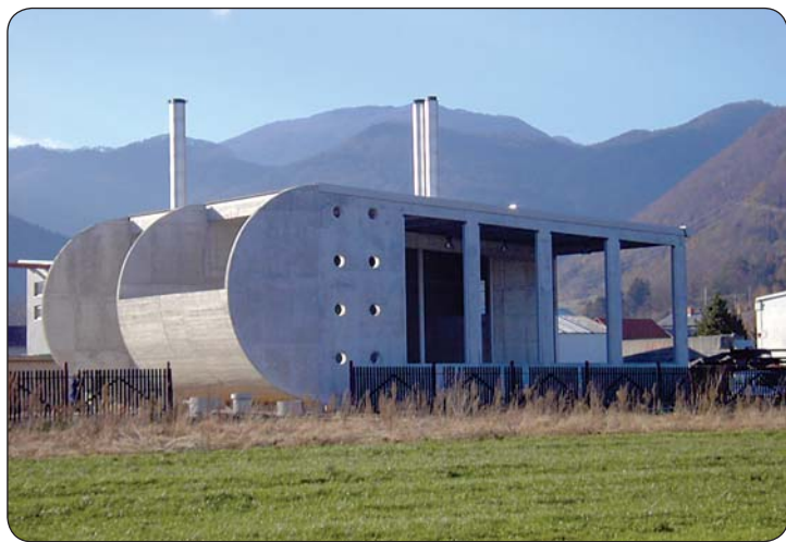
Nova kotlovnica med montažo kotlov
