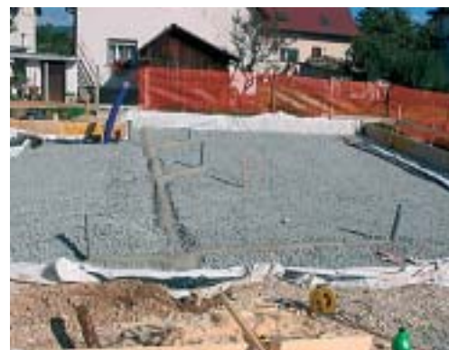
Poravnano nasutje izolacije pod nosilno ploščo.
