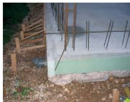
Delna izolacija roba plošče s 15cm »Styrodura«.
