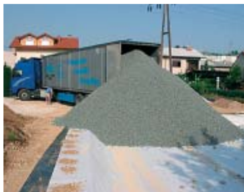
Nasutje izolacijskega materiala – penjenega stekla.
