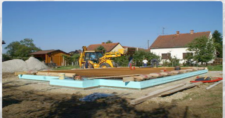
Izolacija temeljne plošče
